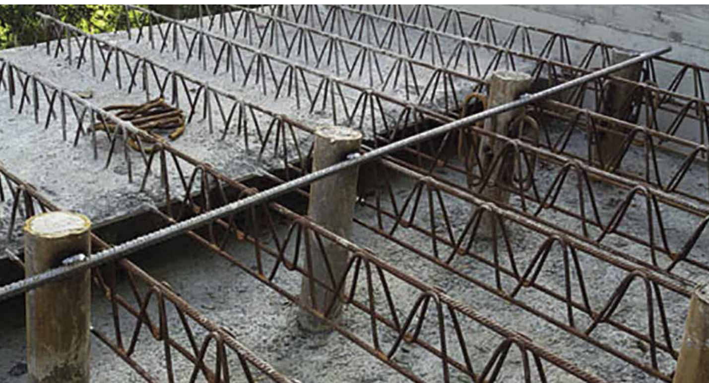
ÉLARGISSEMENT DES ROUTES Mise à niveau de la SP 163 entre Borgo Fornari et Voltaggio. Production de dalles en porte-à-faux ancrées à Micro-pieux pour l'élargissement des routes.
