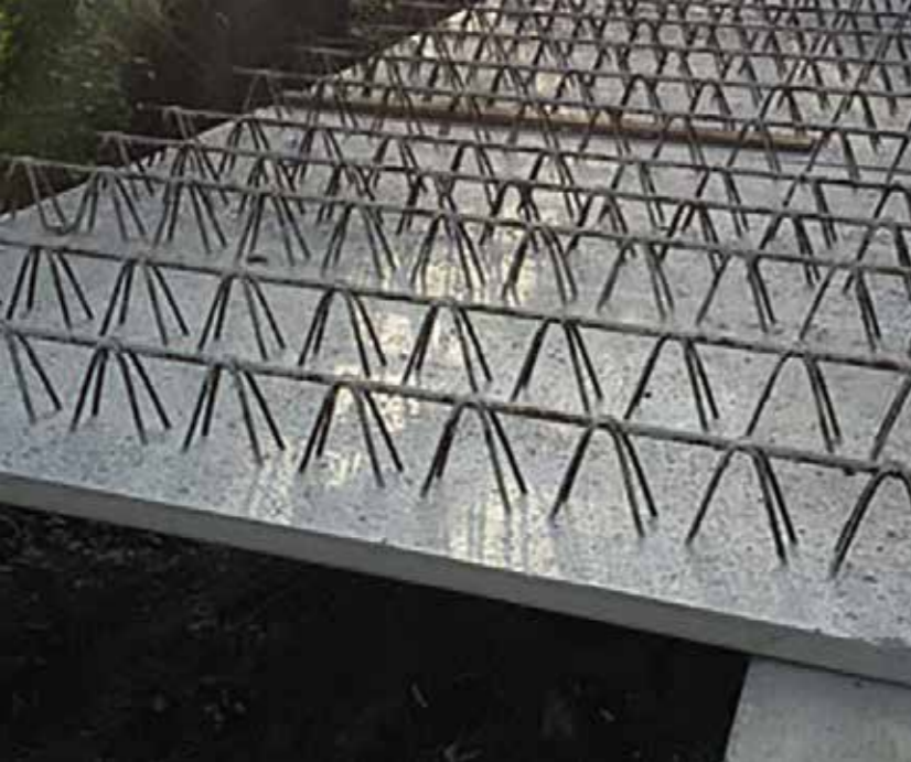
ÉLARGISSEMENT DES ROUTES Mise à niveau de la SP 163 entre Borgo Fornari et Voltaggio. Production de dalles en porte-à-faux ancrées à Micro-pieux pour l'élargissement des routes.
